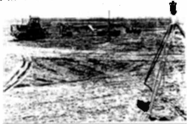
Սկ. 35. Աղուտ հողերի տարածքի հարթեցում (մեխանիզմների բանող օրգանների ընթացքը ավտոմատ կերպով կարգավորվում է լազերով)
