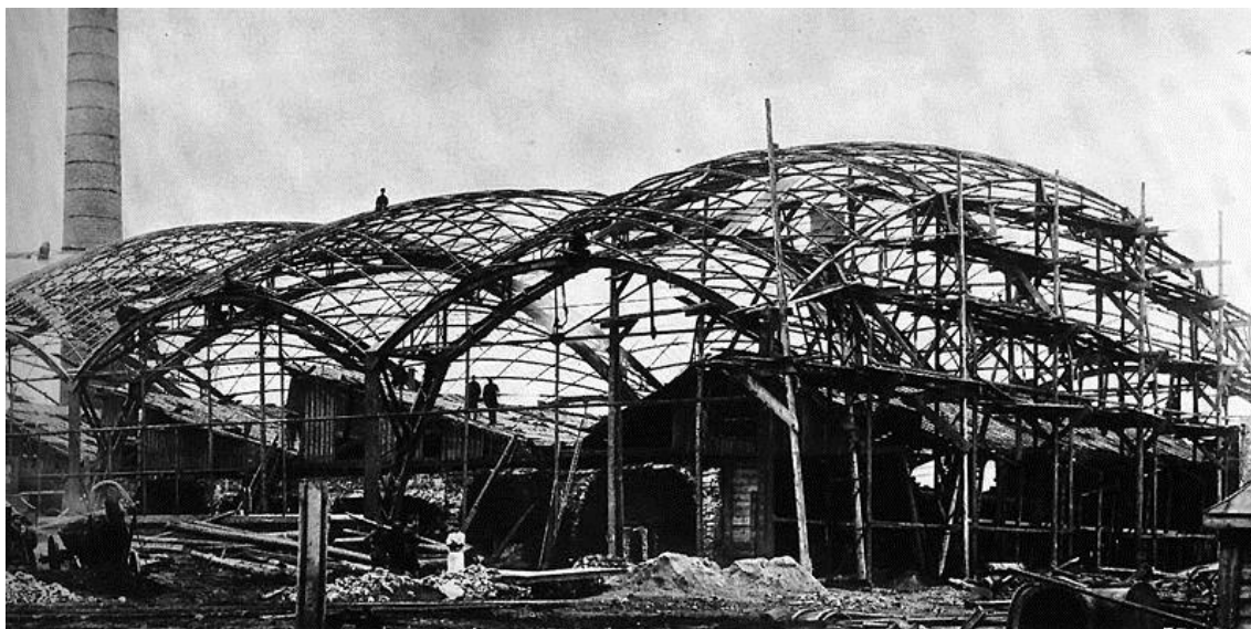
Строительство первых в мире сетчатых оболочек-перекрытий двоякой кривизны конструкции на Выксунском металлургическом заводе в 1897 году.
